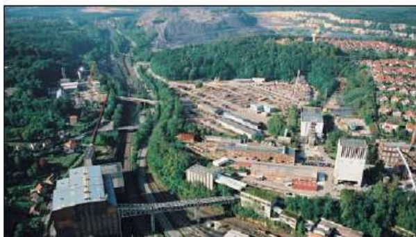
Des reconversions tirant profit de leur passé industriel : le site Vouters
